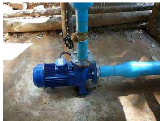
Una de las 2 turbinas utilizadas en el proyecto
